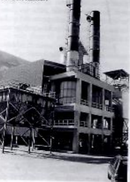
L'impianto di San Raineri
